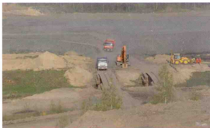
Fot. 1. Transport łupka czarnego na budowę węzła „Sośnica”
